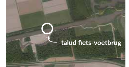
2012 realisatie zuidelijk landhoofd Lagevaartbrug
